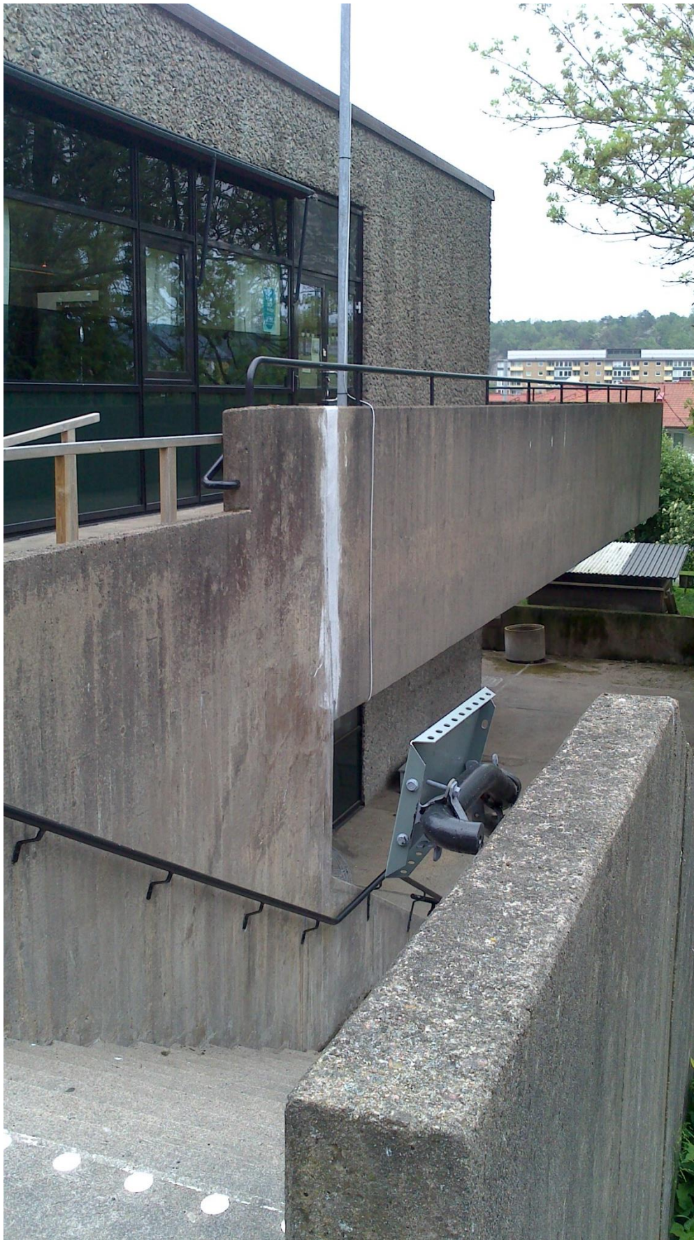
Bild 13. Södra byggnadens gavel, trappa mellan gårdarna.
