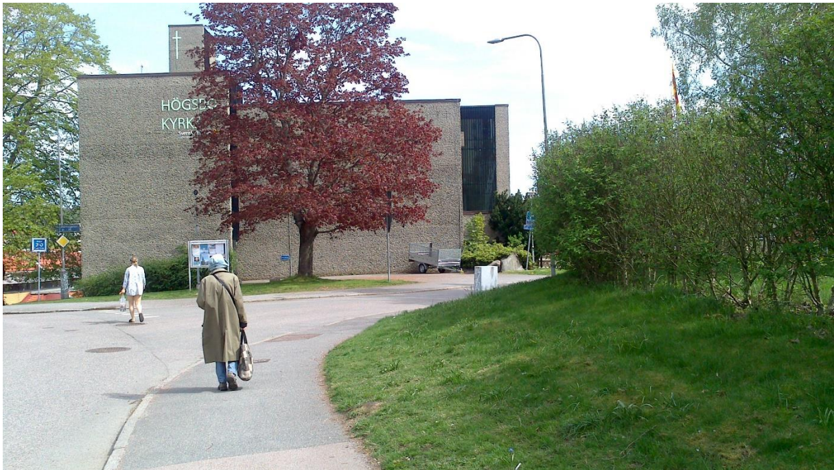
Bild 1. Norra byggnaden, från Bankogatan
