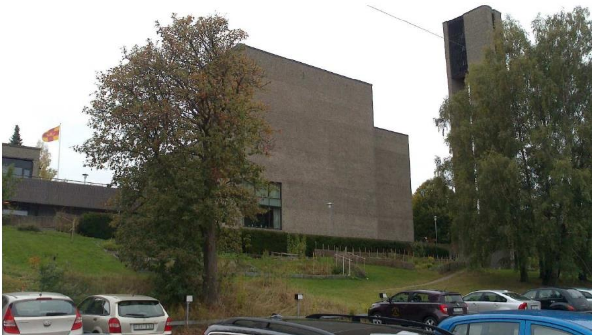
Bild 3. Norra byggnaden och klocktornet, från Kapplandsgatan.
