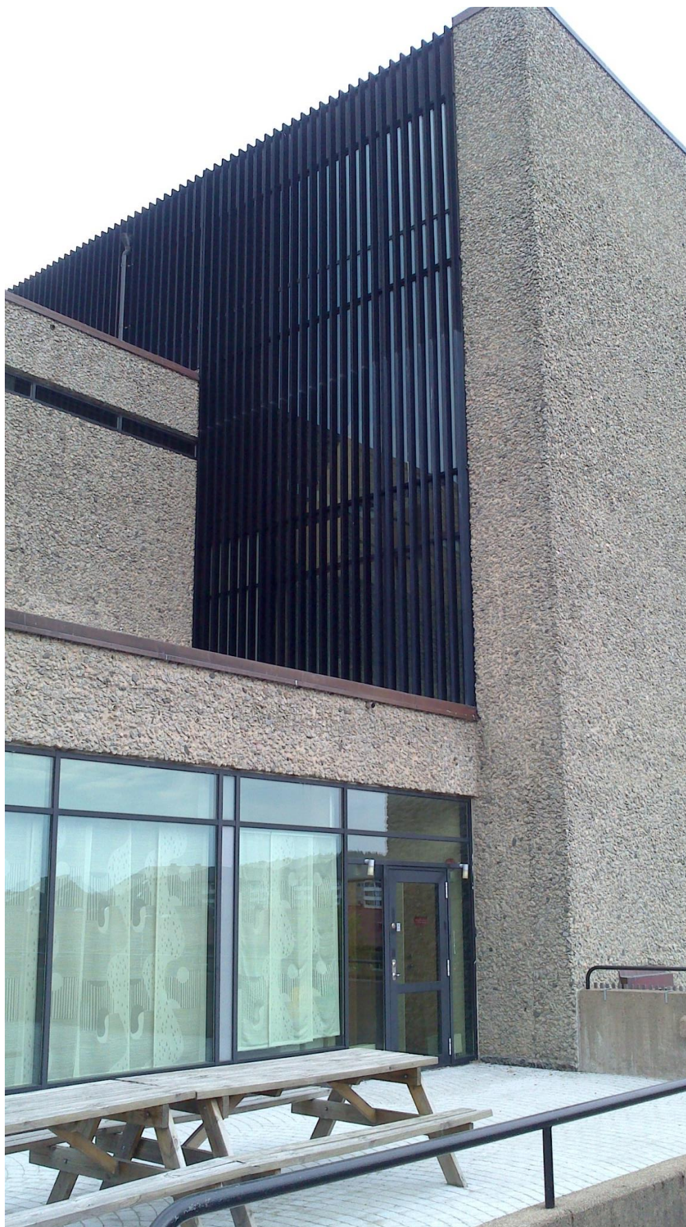
Bild 16. Norra byggnaden, fasad mot gården.
